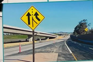
ramp improvements / mejoras en las rampas
